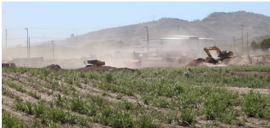
Maquinas de construcción trabajan en la construcción del proyecto urbanístico Ciudad Valle El Ángel, en las inmediaciones del redondel Nejapa-Apopa. FOTO DIARIO CO LATINO/ARCHIVO
