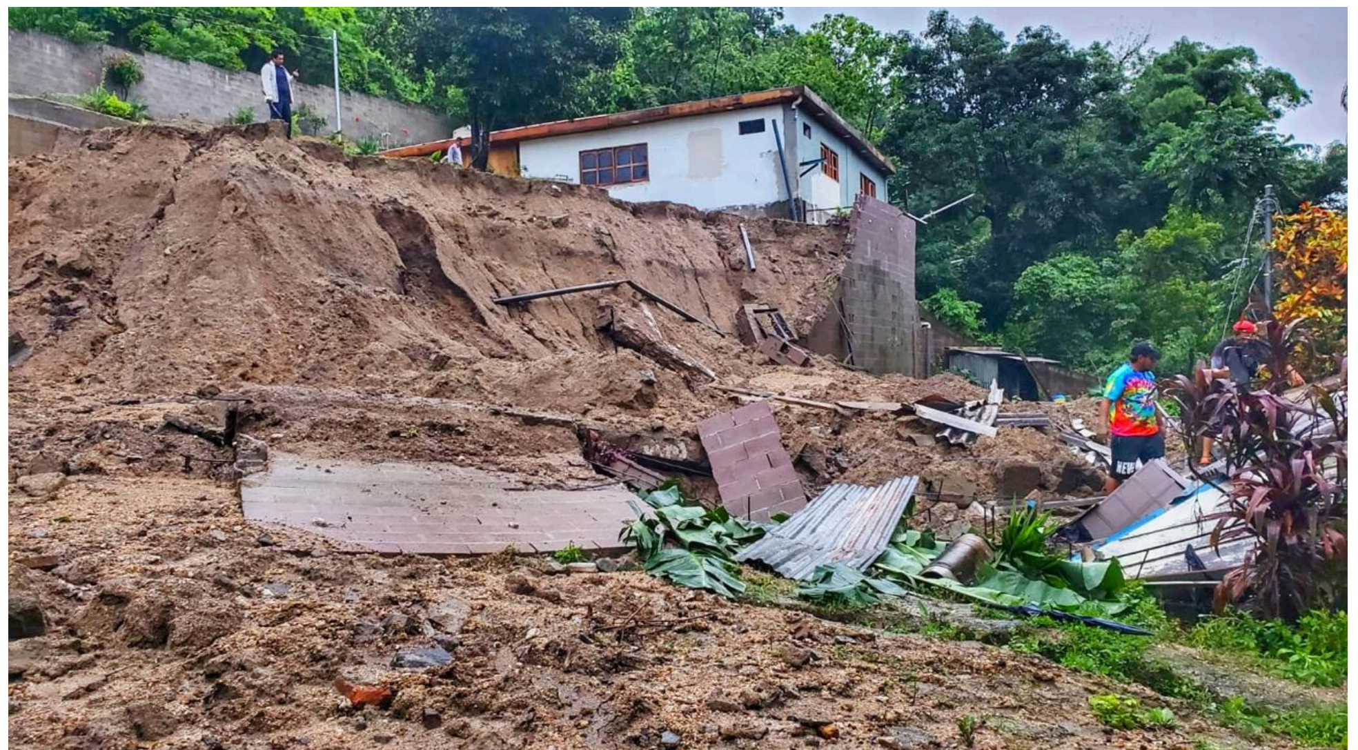
CINCO INTEGRANTES DE UNA FAMILIA FUERON TRASLADADOS A UN ALBERGUE, DESPUÉS QUE SU VIVIENDA RESULTARA DAÑADA POR UN DERRUMBE EN LA PLAYA, CANTÓN JOYA GRANDE, SANTIAGO TEXACUANGOS, SAN SALVADOR. FOTO DIARIO CO LATINO/@PNCSV.
