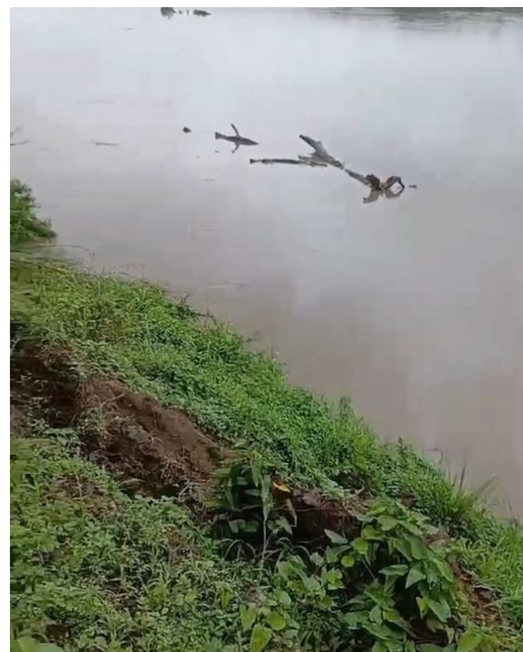
La preocupación de las comunidades en el Bajo Lempa, es el estado de las “bordas de contención” del río Lempa, que están siendo debilitadas por la fuerza del agua. Foto Diario Co Latino/CRIPDES.
