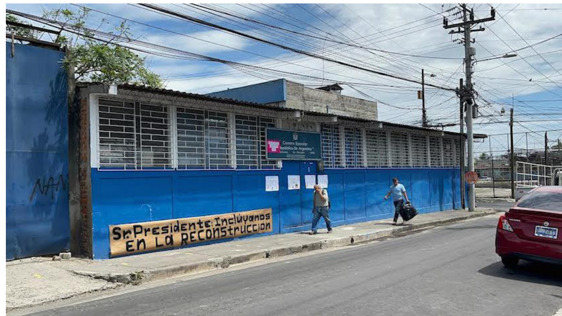
La escuela ubicada a un costado del ex cine libertad será demolida para construir un parqueo. Foto: Diario Co Latino / Samuel Amaya.
