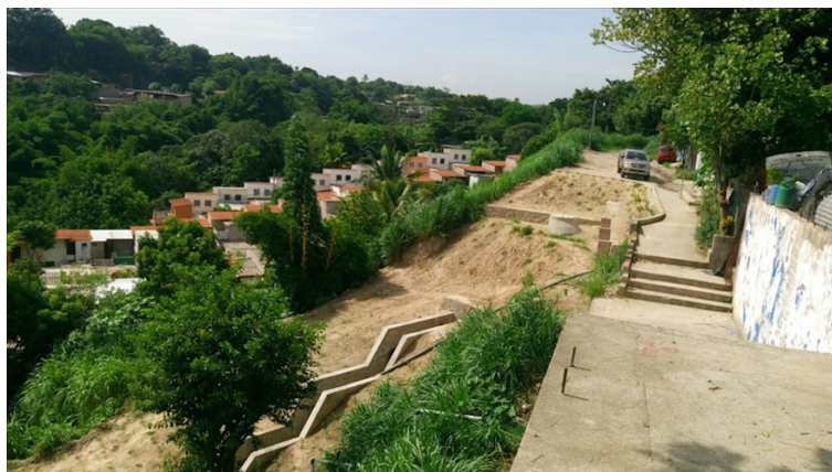
La DOT recibirá un aporte inicial de $2 millones del Centro Nacional de Registro (CNR), además de ingresos por tasas de de servicios, transferencias de bienes e inmuebles y donaciones.
