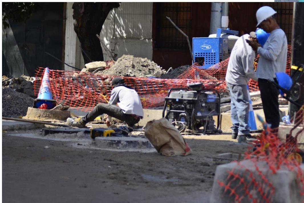
**“Están demoliendo las cajas del sistema de cableado subterráneo, grandes planchas de concreto con un marco de acero, fueron mal colocadas y con el paso de los carros se dañaron”.**
