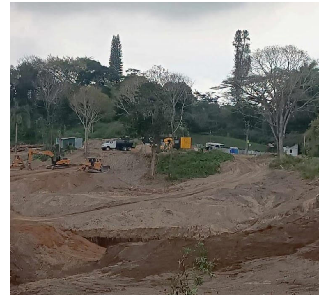
Fotografía tomada por un habitante de la zona donde se observa los trabajos y la maquinaria. Foto: Diario Co Latino / Cortesía.
