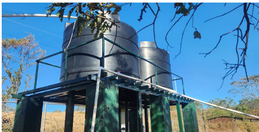
El proyecto en la comunidad La Barranca y Las Promesas, se beneficia de un sistema de agua con tanques elevados para el bombeo de agua con el aprovechamiento del principio de gravedad, que tienen la capacidad de 5 mil litros que abastecen a diario con agua domiciliar”, Foto DiarioCoLatino/Gloria Orellana.
