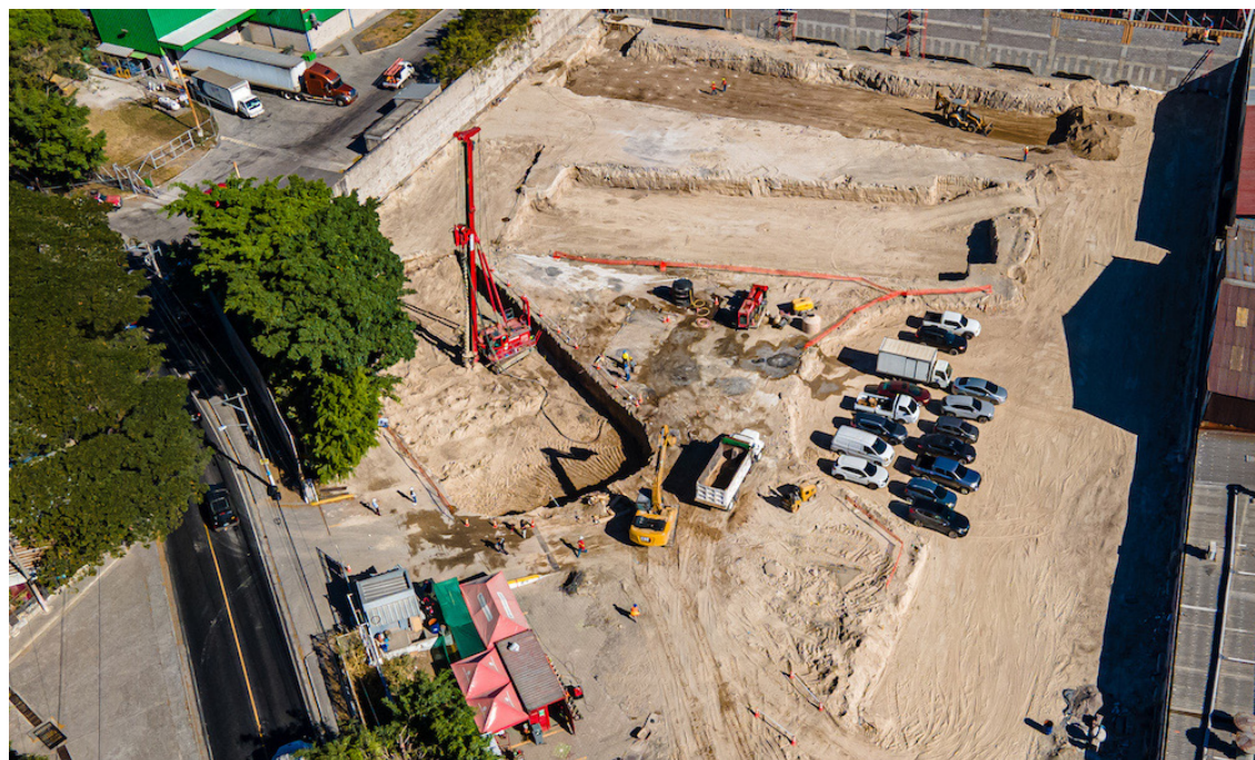
El proyecto inmobiliario contará con tres torres de 9 niveles cada una, que serán construidas con muros de carga de concreto reforzado, para una “seguridad máxima”. Foto Diario Co Latino/Cortesía.
