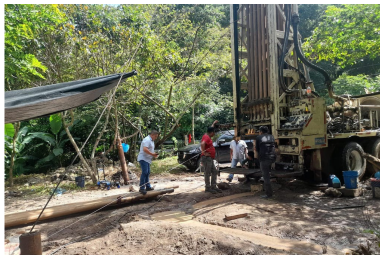
Proceso de perforación del pozo a través de PROVIDA y apoyo financiero del Colectivo El Salvador Elkartasuna, el Gobierno de Navarra y ARDM. Foto Diario Co Latino/Cortesía.
